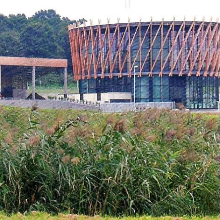
Heizkraftwerk fügt sich gut in die Umgebung ein: zylinderförmige Lärchenummantelung
